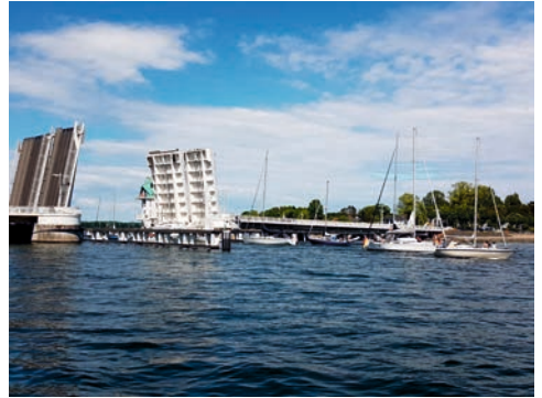
Die Klappbrücke in Kappeln
