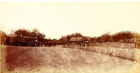
Barackenlager bei Laboe für die Unterbringung der Mannschaften der Waldbatterie
