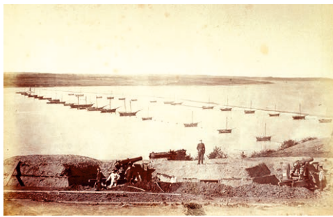
Tau- und Kettensperren, die von Schiffen getragen wird. Im Vordergrund die Schanze der Jägersberg
