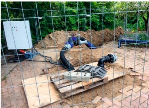
eine Baustelle eingerichtet, die voraussichtlich ca. 3 Jahre bestehen wird. Das alte Pumpenhaus neben der ehemaligen Schlosselei von Jan Kruse wird komplett neu ausgebaut und vergrößert sowie die umliegenden Rohrleitungen und Kontrollschächte neu verlegt, um dem erhöhten Bedarf an Abwasserdruckleitungen von Wendtorf, Stein und Laboe zum Klärwerk Bülck auf der westlichen Seite der Förde gerecht zu werden.
